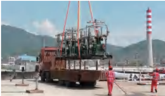
仓储物流吊装
