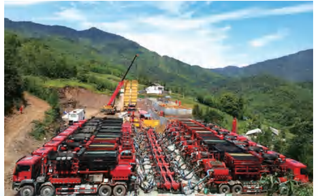
压裂施工现场技术指导
