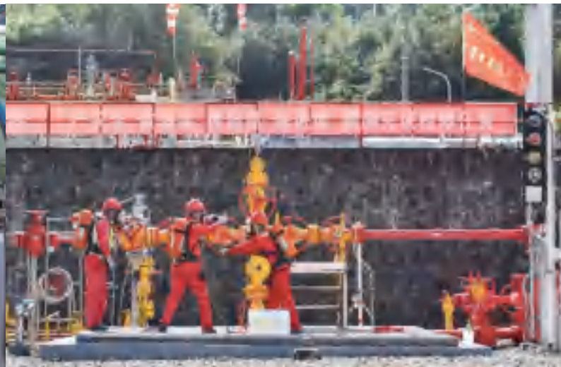
井口装置巡检
