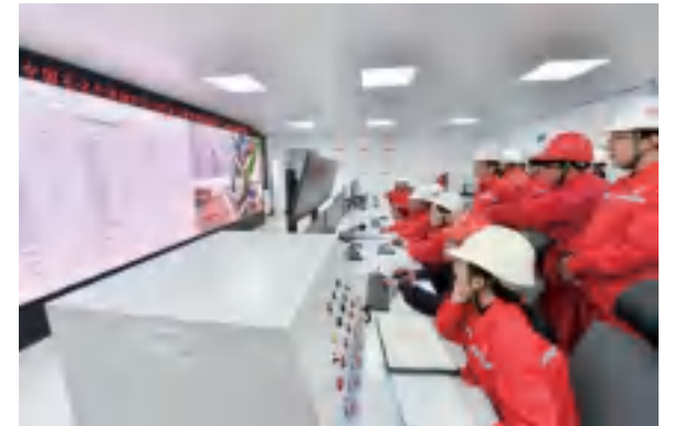
储气库中控室
