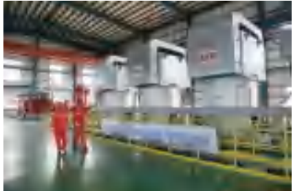
LNG 海水泵房运维
