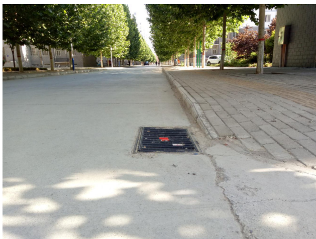
住宅区道路及排水
